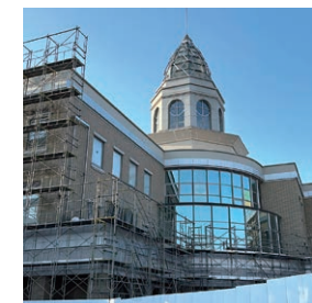
改修工事中の尾上分庁舎
