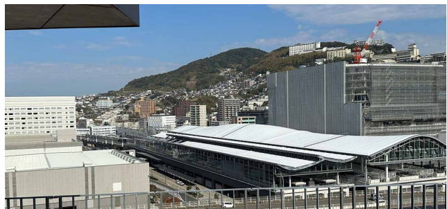
図7 右は建設中の新駅ビル。中央が長崎駅。左側の建物群が出島メッセ長崎。(2022年11月、櫛引撮影)
