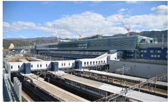
図3 工事が進む敦賀駅 (2022年11月、櫛引撮影)
