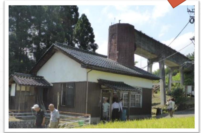
地域による地域のための小水力 別府小水力発電所 （鳥取県鳥取市用瀬町別府）
